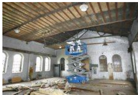
Regenerationshuset. Här ska det bland annat bli restaurang. Men först måste tak och golv rivas ut och det giftiga källargolvet saneras. Foto:
